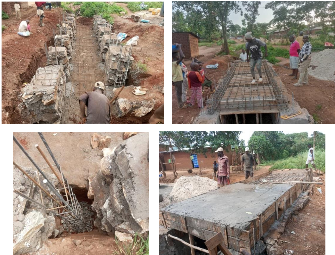
Photos : différentes étapes de la construction du pont
